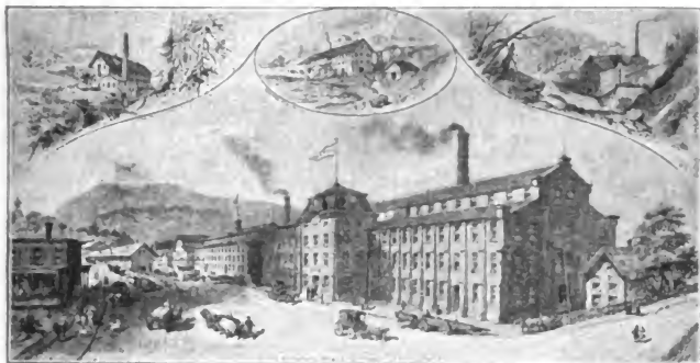
ALFRED DOLGE'S DOLGEVILLE FACTORIES.
